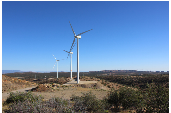
Parque eólico en Baja California, México. Autor: Minerva Uribe-Rivera, Universidad de Baja California
