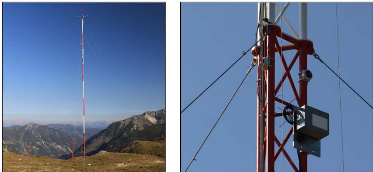
Abbildung 13: (links) Windmessmast mit der Sensorinstallation im unteren Bereich; (rechts) Nahaufnahme des Sensorsystems.
