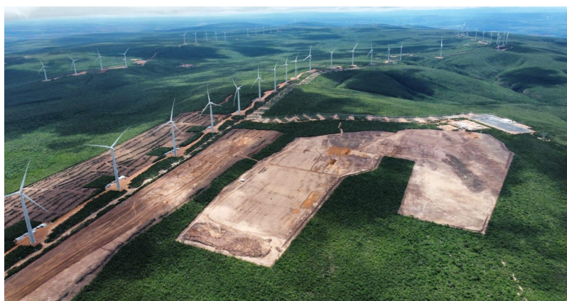
Figura 2: Complexo Híbrido Solar Eólico Ventos de Santa Eugênia.
