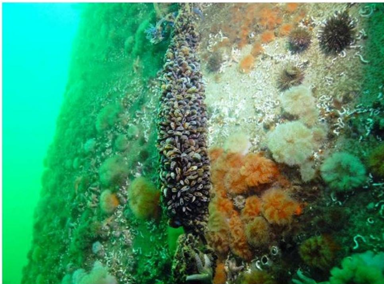
Figure 94 : Colonisation d'un pieu en Mer du Nord (Degraer et al., 2012)
