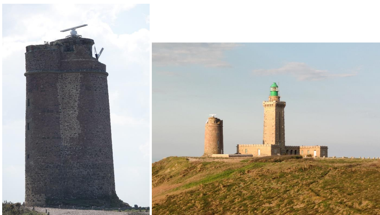
Figure 6 : Vue globale de l'installation des radars sur le site du cap Fréhel
