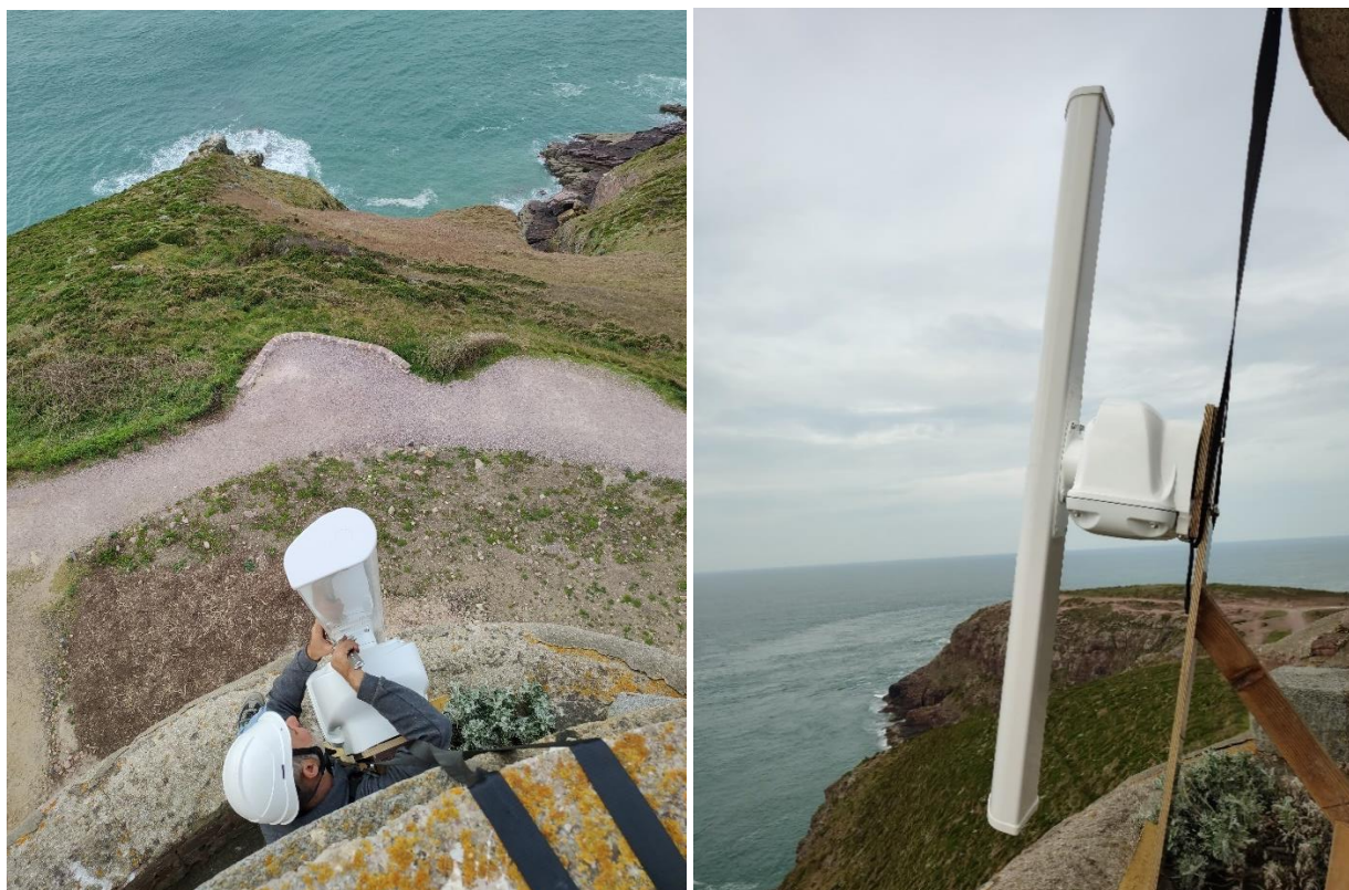
Figure 5 : Installation du radar en bande-X sur la tour Vauban
