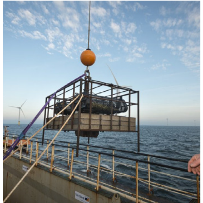
Figure 19 & 20: Placing shell substrate and oyster cages (photos: ARK Natuurontw. & Bureau Waardenburg).
