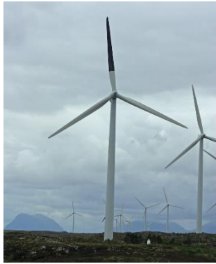
Figure 7 : Eolienne avec une pale peinte en noire.
