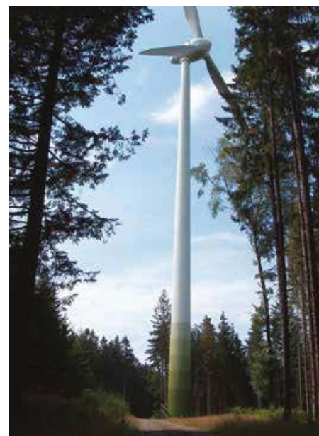
Das Errichten von Windenergieanlagen im Wald ist für Fledermäuse sehr gefährlich und wird daher in den vorliegenden Leitlinien nicht empfohlen und kritisiert. © H. Schauer-Weissahn & R. Brinkmann
