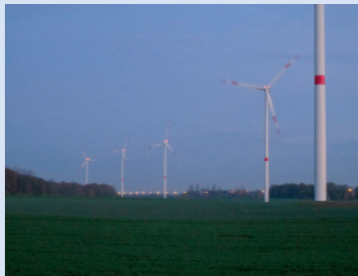
Η άδεια που δόθηκε για αυτές τις 5 ανεμογεννήτριες (Perwez, Wallonia, Βέλγιο) περιλαμβάνει πτέρωση (feathering) των πτερυγίων γιατί μεταναστευτικά είδη νυχτερίδων είχαν καταγραφεί κατά τη διάρκεια της ΕΠΕ. © T. Kervyn
