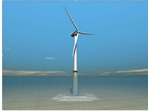
Figura 6: Representación en 3D de aerogenerador offshore tipo monopilote-Fuente: ASDReports
