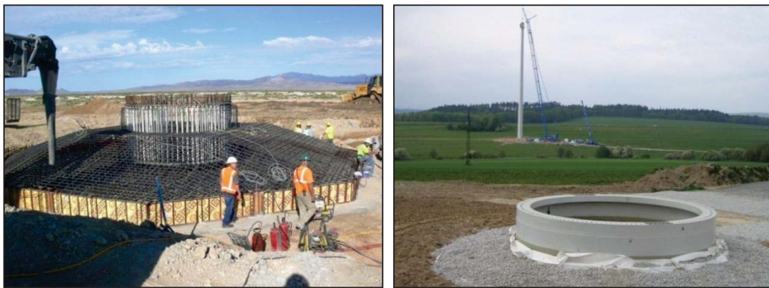
Figura 5-4: Detalle construcción base octogonal y finalizada
