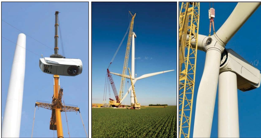
Figura 5-5: Proceso de montaje
