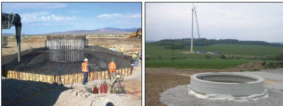
Figura 3-4: Detalle construcción base octogonal y finalizada
