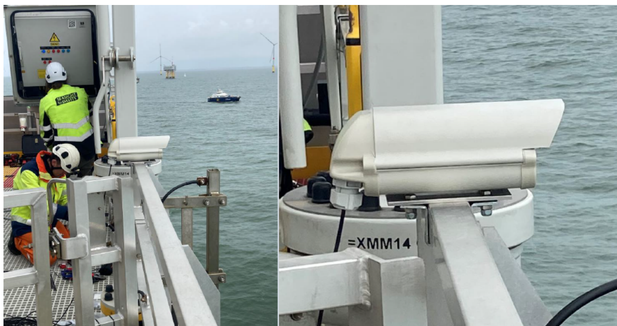
FIGURE 12 : SYSTÈME D'INSTALLATION DES CAPTEURS DES BATLOGGERS EN 2024
